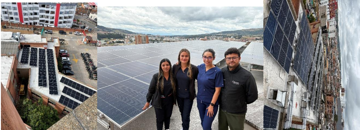
Imágenes: Montaje del Sistema de Autogeneración Fotovoltaico
